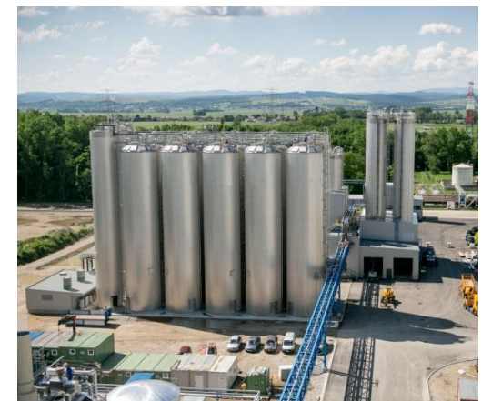
Weizenstärkefabrik Pischelsdorf, Österreich
