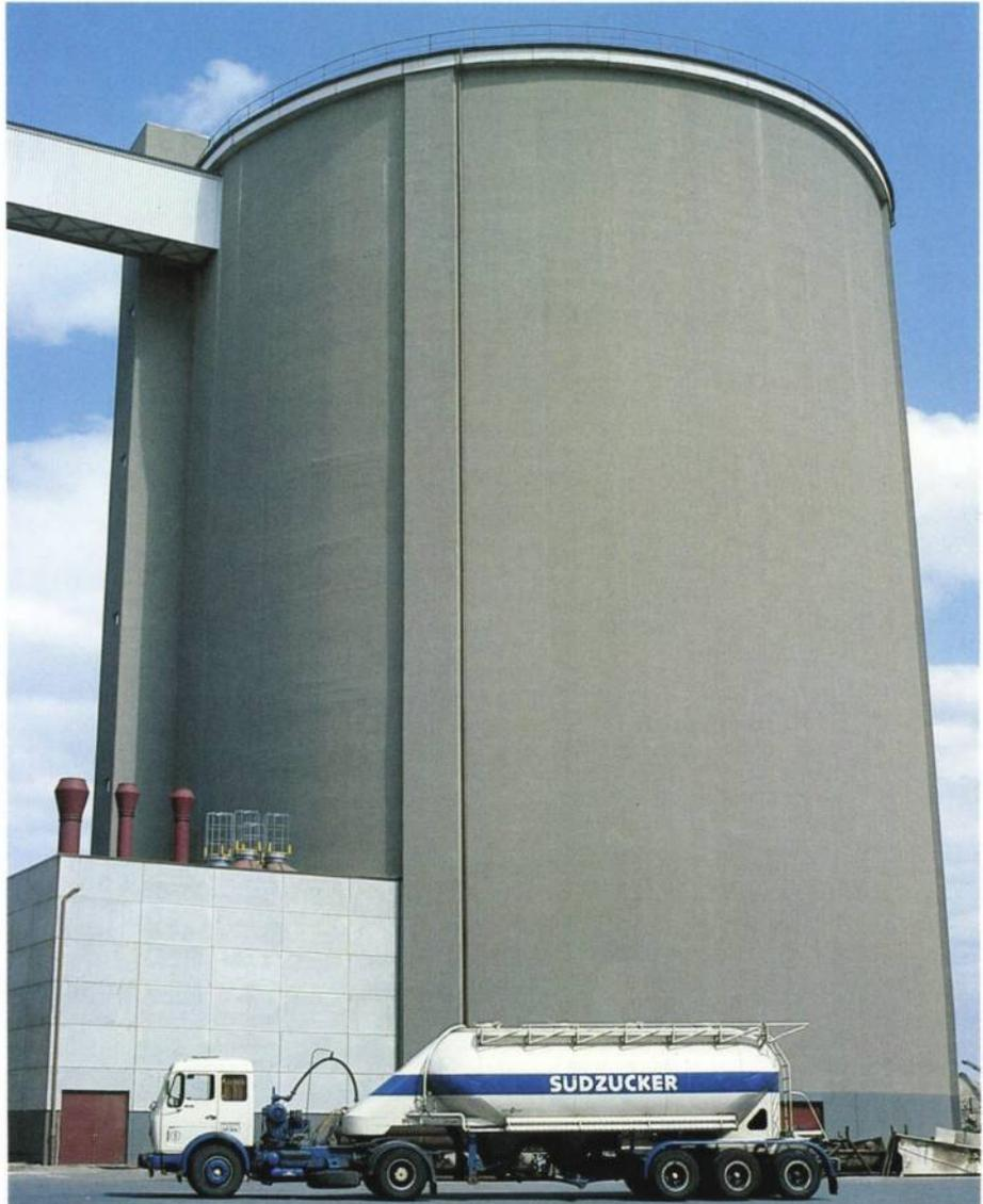
Foto: Der neue Zuckersilo im Werk Groß-Gerau mit einem Fassungsvermögen von 35.000 t.
