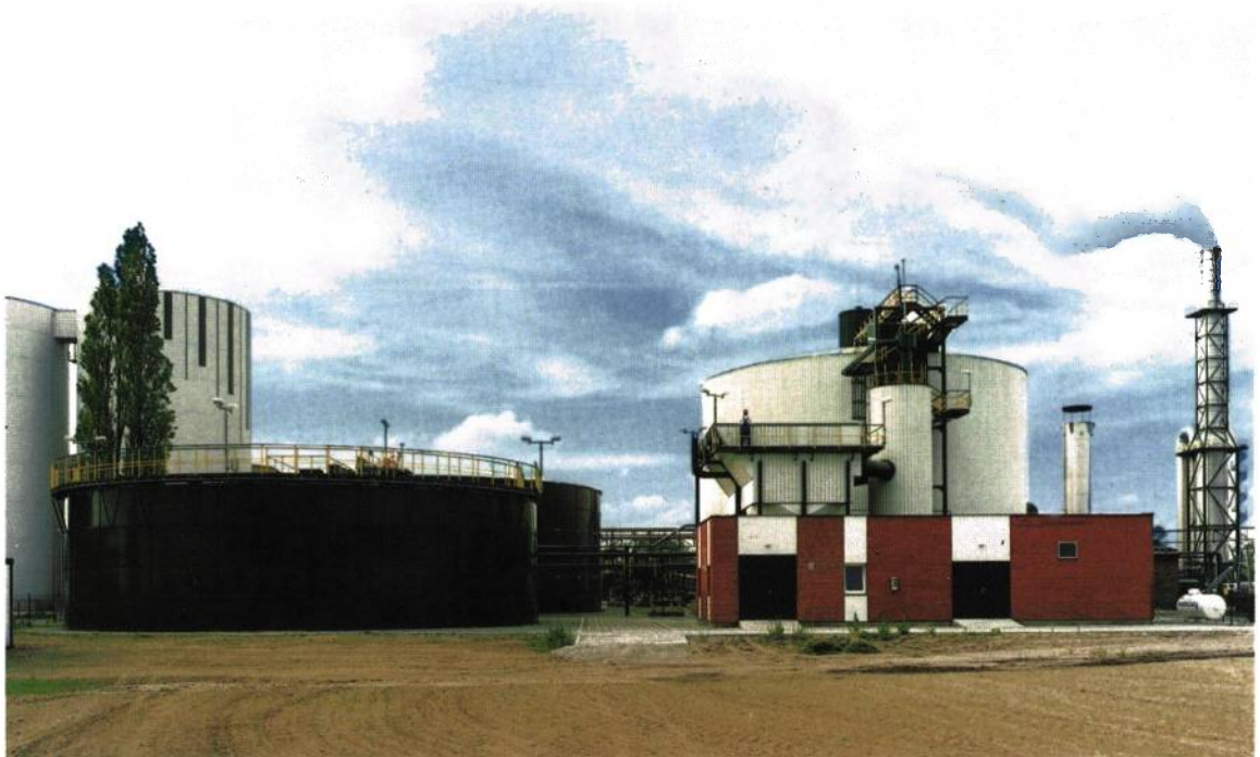
Werk Brottewitz: Nitrifikation/Denitrifikation Anaerobreaktor Biogasfackel Rauchgasreinigung
