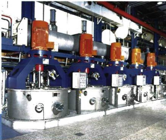
Werk Ochsenfurt, neue Zentrifugenstation.
